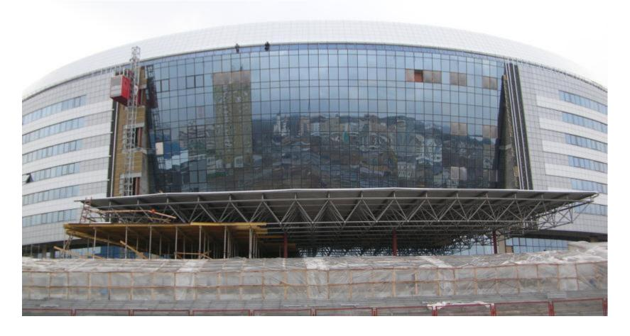
Высота структуры в осях – 1,7 м, ширина покрытия – 17,71 м, длина покрытия по наружной дуге – 45,72 м
