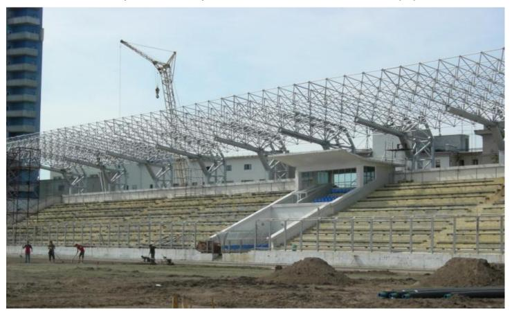
Размер структурной плиты в плане – 131,0x14,0 м, высота плиты в осях – 1,414 м, размеры ячеек поясных сеток – 2,0x2,0 м, 2,0x2,125 м и 2,0x2,25 м
